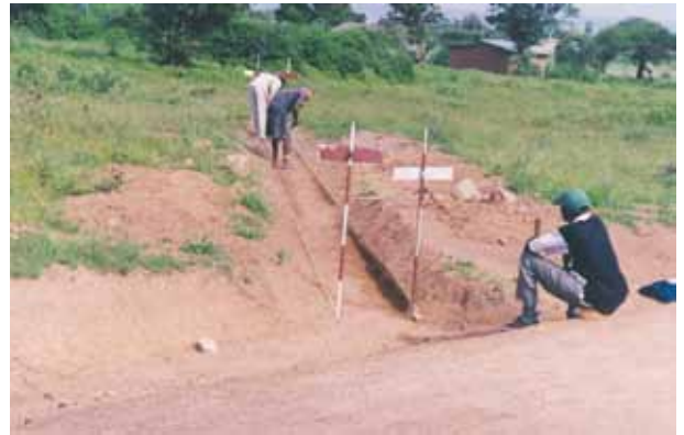
Setting out a mitre drain
