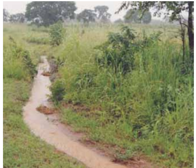
A functioning mitre drain
