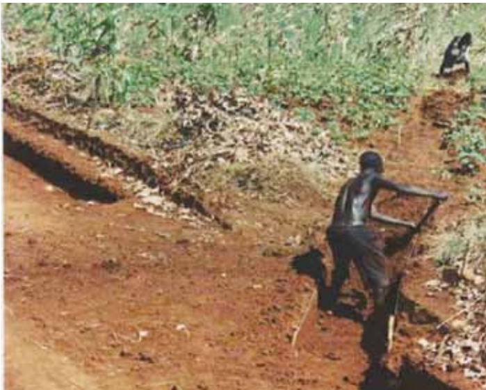
Excavating a mitre drain
